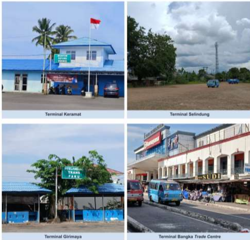
Gambar 3.2 Kondisi Eksisting Terminal di Kota Pangkal Pinang
